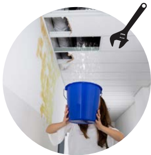
J'ai un dégât d'eau
